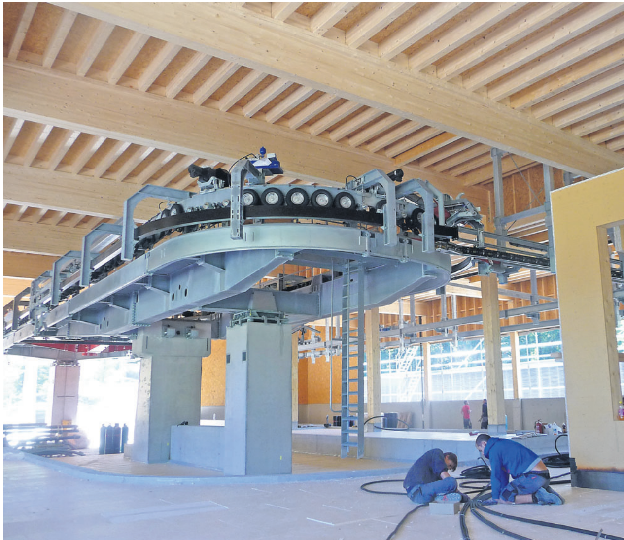
Talstation Mellaubahn: innen Holzkonstruktion mit dem Einstiegsbereich. (Foto: Bergbahnen Mellau)
